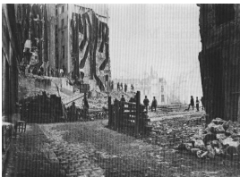
Construction of the avenue de l'Opéra.
